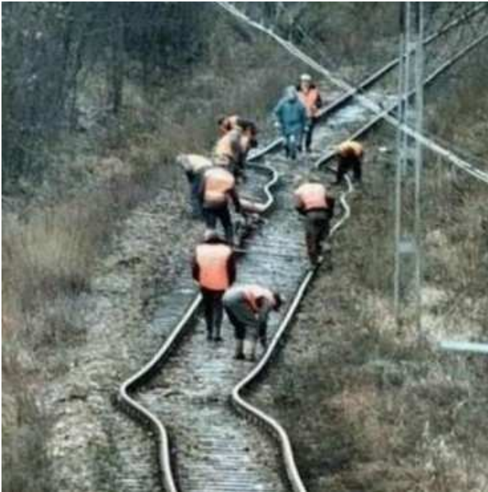
Figure 4.1 – Flambement de rails sous l'effet de la dilatation thermique
