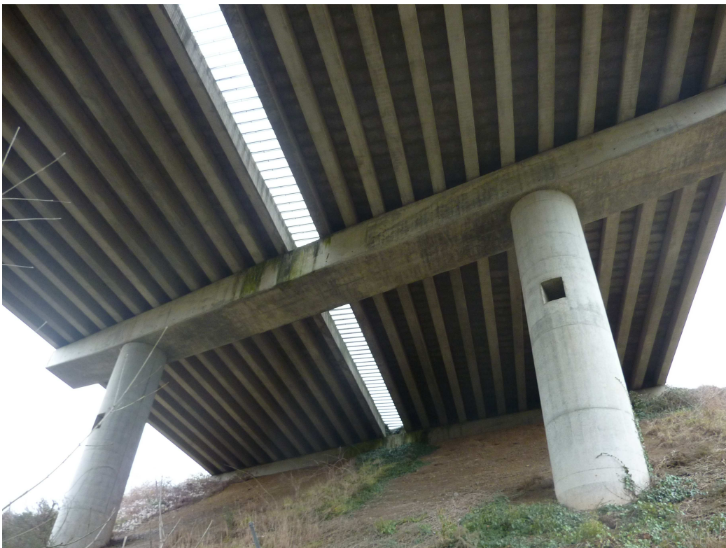
Figure 2.1 – Poutre de soutien d'un tablier de pont
